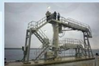
상부 설비 설치
